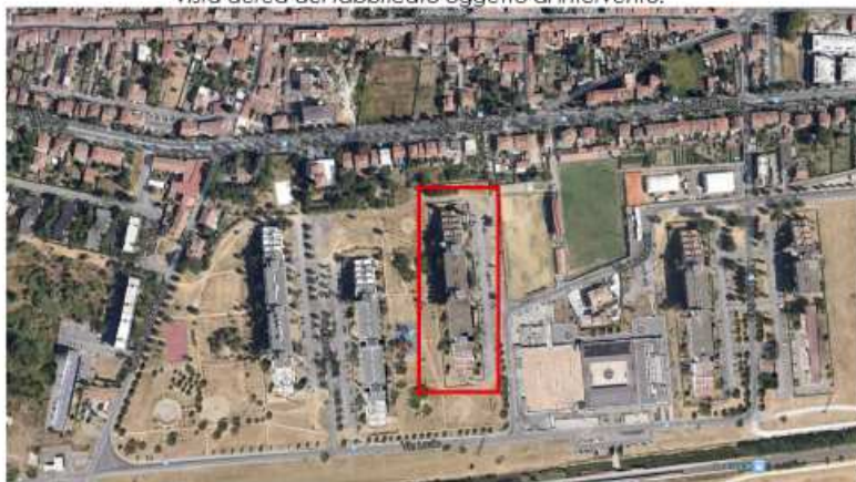
Vista aerea del fabbricato oggetto di intervento.
