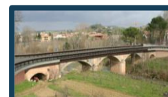
Adeguamento Ponte SP64 Km 7+700
