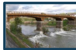
Adeguamento Ponte sulla SP106 Km 7+145
